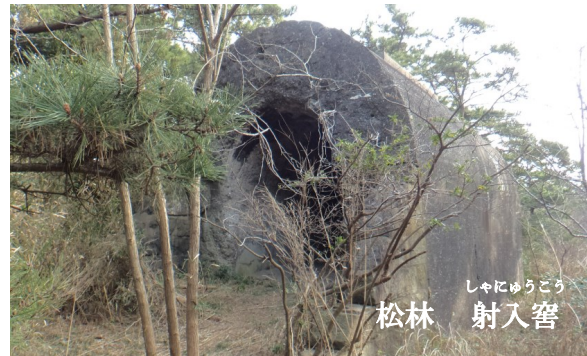
かんてきじょ 松林 監視所
